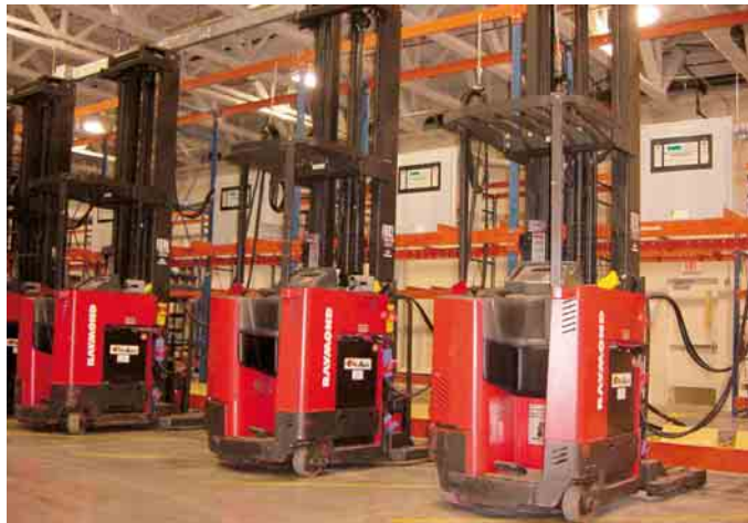
Mit der Technologie „PosiCharge“ laden die Flurförderzeuge ihre Batterien an dezentralen Ladestationen
