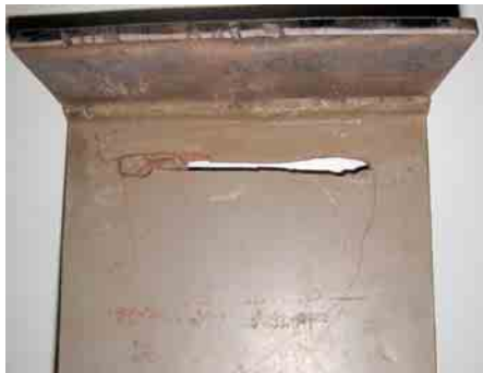
3 Rissverlauf auf der Gurtunterseite bei unterbrochen geschweißter Schienen-Halsnaht und breitem abstehenden freien Gurtrand
