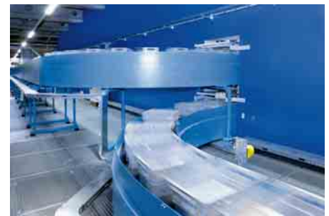
Anbindung der Quergurtsortererführung an das automatische Hochregallager
