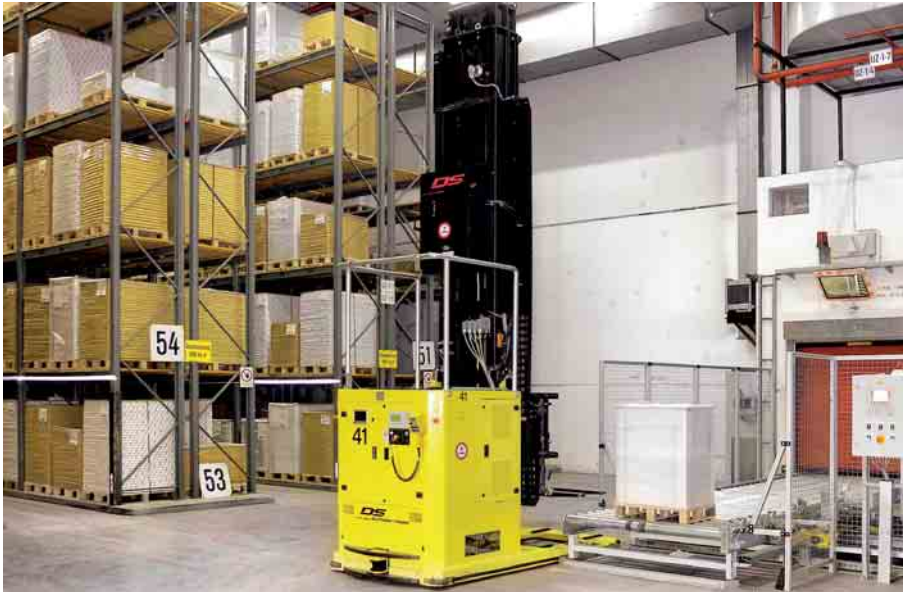
Funktionierende Intralogistik: FTF, die stationäre Palettenübergabe und das Hochregallager
