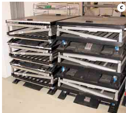
a) Die Bauteile sind in Einbau-reihenfolge auf rollbaren Wagen sortiert und werden per Lkw doppelstöckig angeliefert
