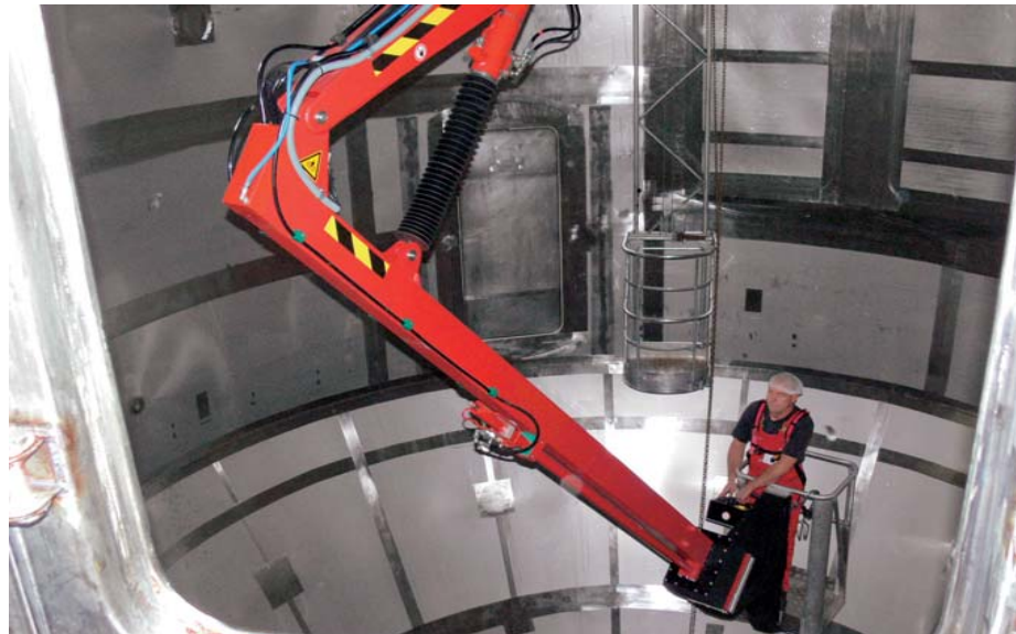
1 Alte und neue Lösung im Vergleich: hinten die bisherige, am Galerierand aufgehängte Arbeitsplattform (inzwischen demontiert) und vorn der Arbeitskorb der teleskopierbaren Bühne
