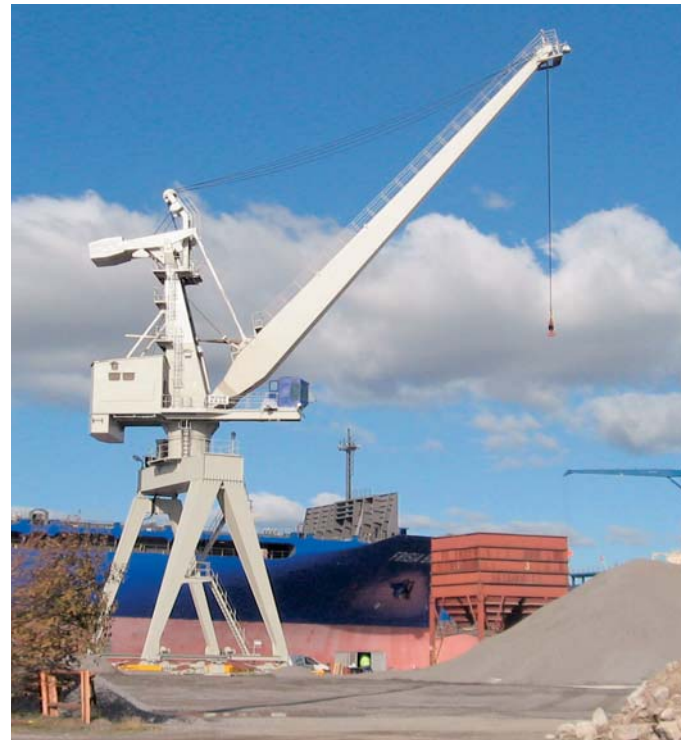
Der modernisierte Portal-Wipp-Drehkran von Ems-Beton im Emdener Hafen (Bilder: Konecranes)
