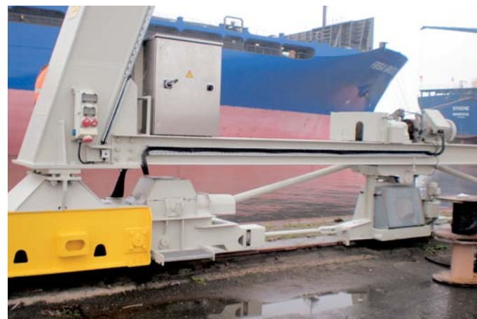
Installation der wasserseitigen Fahrwerksträger
