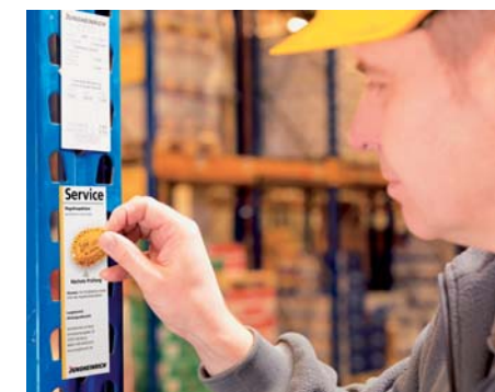
Die Plakette bestätigt die fach- und sachgerechte Durchführung der jährlichen Inspektion
