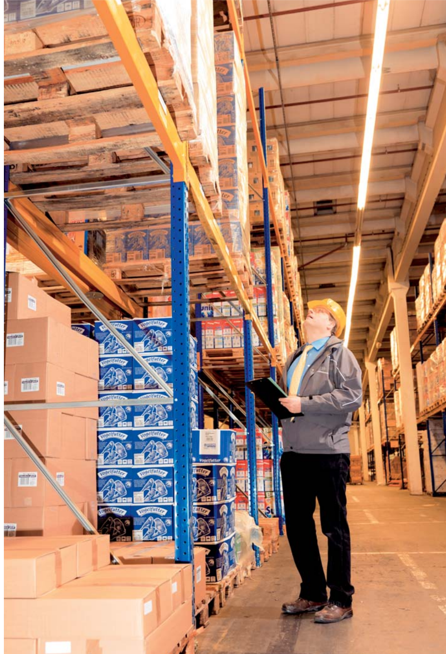
Auf Inspektion: Die Sichtkontrolle der Regalanlage erfordert fundierte Kenntnisse
