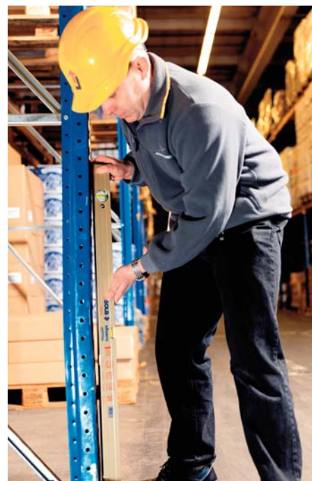
Wichtiges Element: Die Regalständer werden auf Beschädigungen und Verformungen untersucht
