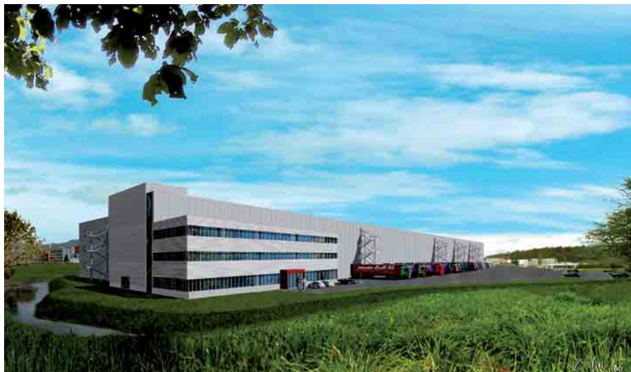
2 Das neue Distributionszentrum von C&A in Buchs hat einen Durchsatz von bis zu 200000 Teilen pro Tag
