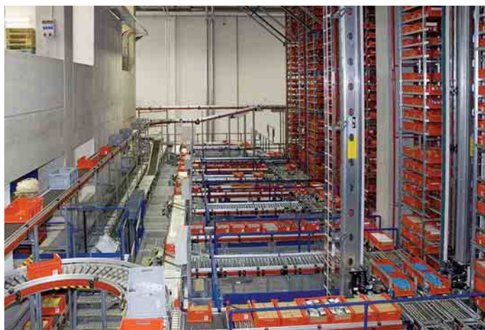
4 Automatisches Kleinteilelager mit Regalbediengeräten „Stratus“ und Vorzone
