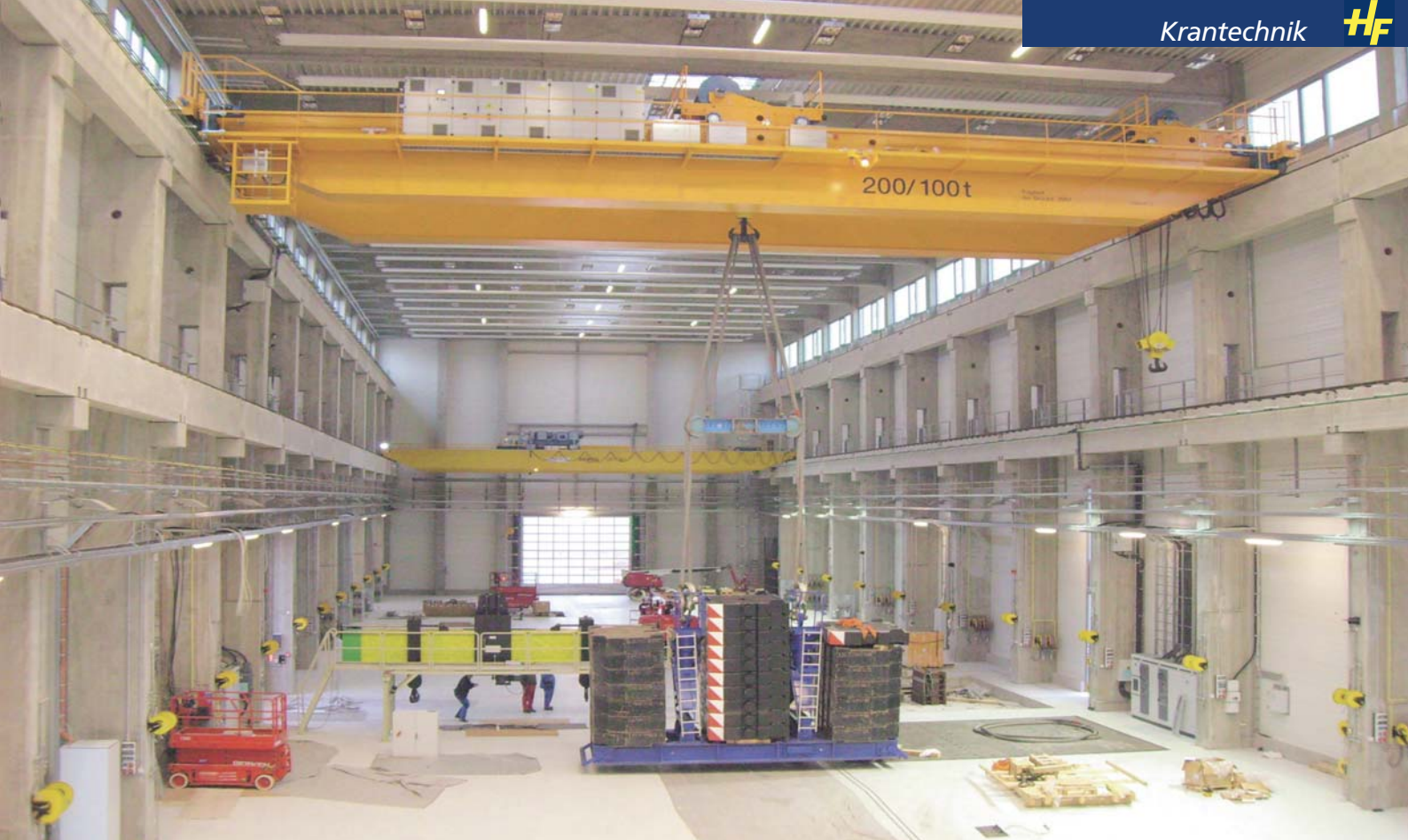
Prüfung eines Brückenkranes: Mit Hilfe von Prüflasten lassen sich unterschiedliche statische und dynamische Eigenschaften beurteilen
