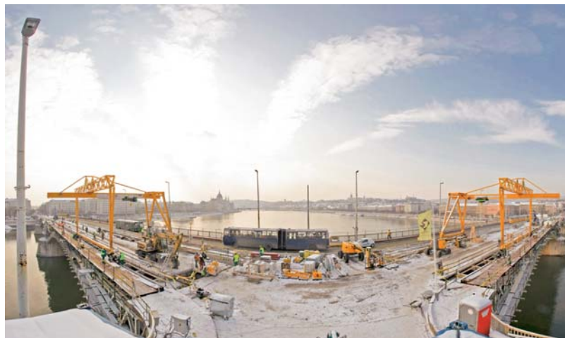
Blick von der Mitte der Brücke auf der Margareteninsel: jeder der beiden 16-t-Portalkrane befährt auf einer 320 m langen Kranbahn eine Hälfte der Brücke
