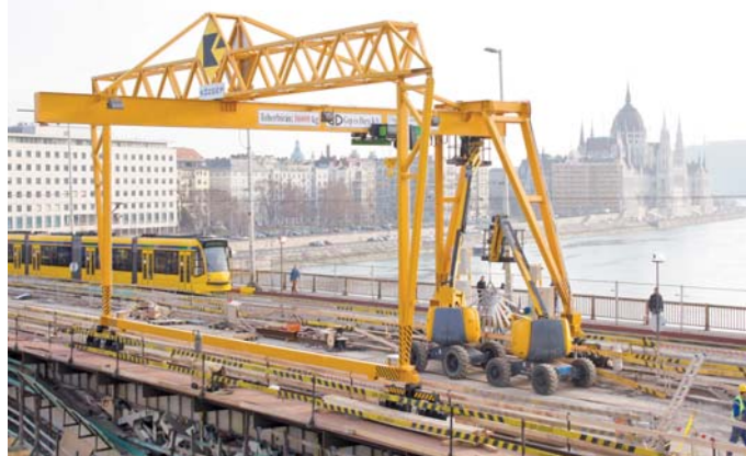
Ungewöhnliche Konstruktion: Spezial-Portalkran mit 5 m langem Ausleger, einem Stützenabstand von 18 m und einer Hubhöhe von 15 m
