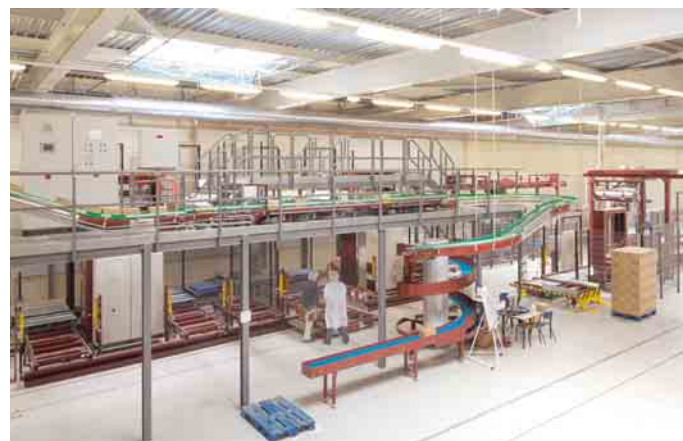
Alle Einrichtungen der Vorzone und des Lagers wurden auf höchste Funktionssicherheit ausgelegt
