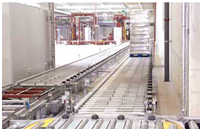
Die installierte Horizontalfördertechnik ist für Paletten bis 1 000 kg geeignet
