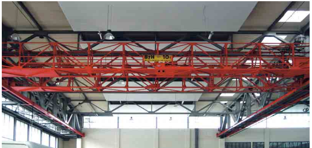
Gelungene Modernisierung: Die denkmalgeschützten Krane aus dem Baujahr 1937 erstrahlen am Bundeswehrstandort in Fritzlar in neuem Glanz
