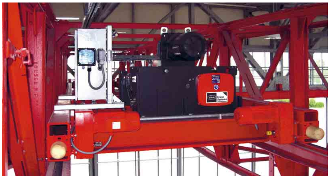
Leistungsstarke Kombination der Modernisierungspartner: Modernste Krantechnik und bewährte Funktechnik
