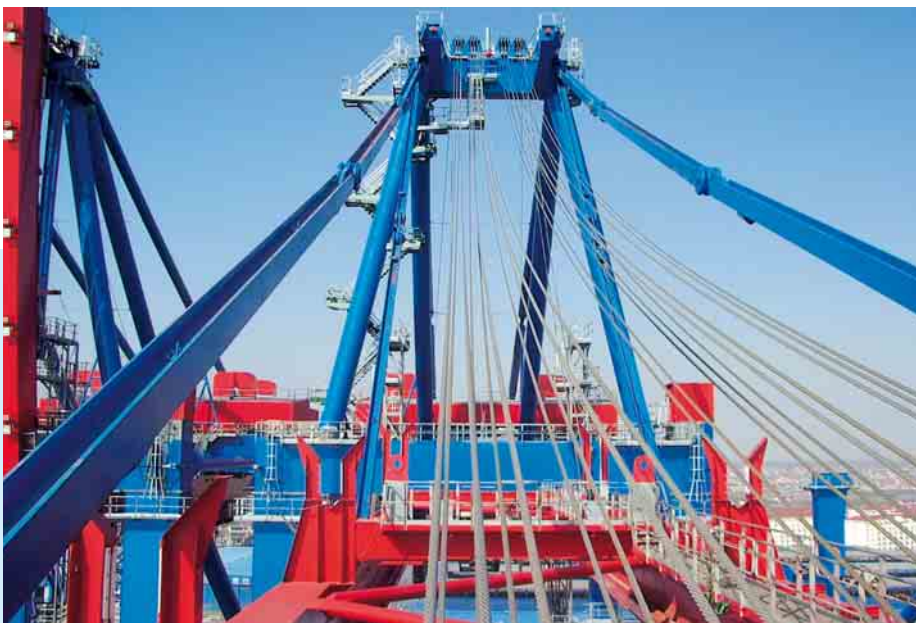
④ Pylon und Zugbänder
