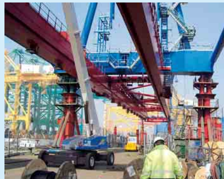
② Wasser- und landseitiger Ausleger sowie Pylon vor der Montage
