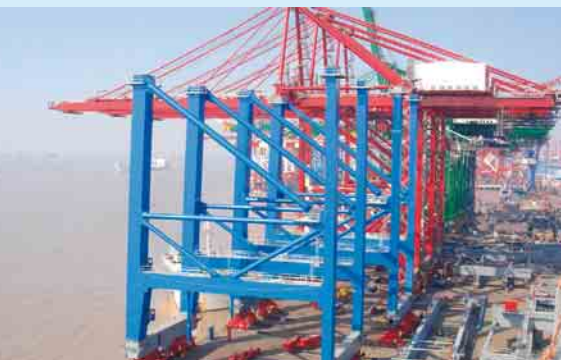
① Montage der Fahrwerksbalken und Portalrahmen
