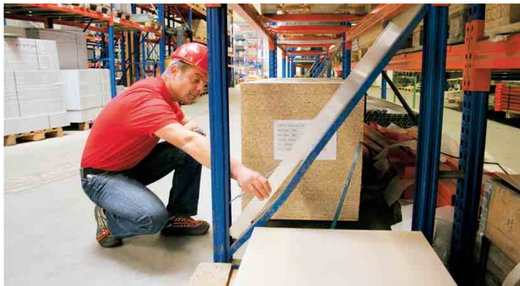
Verbandsgeprüfte Regalinspektoren kontrollieren einmal pro Jahr den Zustand der Lagertechnik
