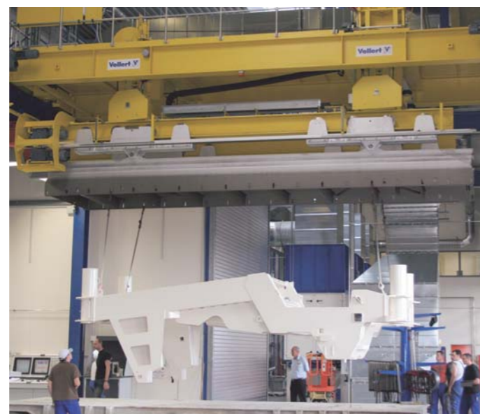
2 Am Beginn der Anlage übernimmt ein deckengeführter Be- und Entlademanipulator mit Hubwerk den Transport der Werkstücke zwischen den Strahl- und Vorbereitungsplätzen
